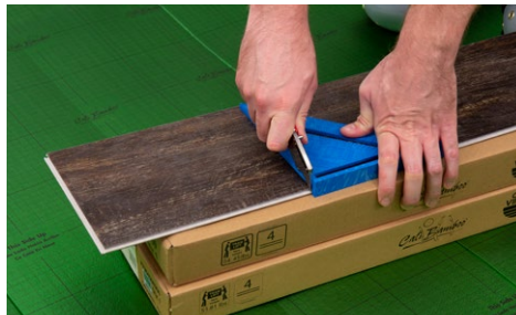
Méthode de coupe de planches "Entailler et casser", à utiliser selon la qualité de coupe souhaitée.
