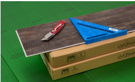
Méthode de coupe de planches "Entailler et casser", à utiliser selon la qualité de coupe souhaitée.
